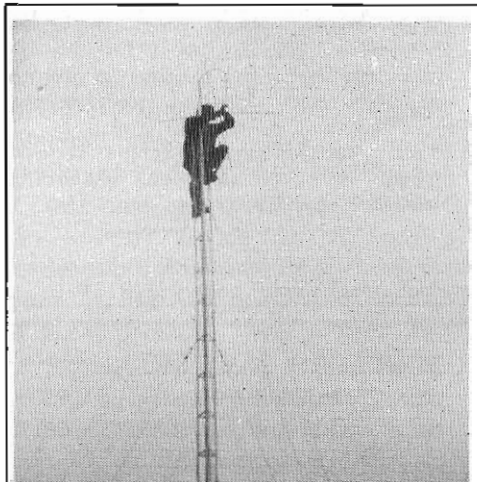
De laatste hand wordt gelegd aan de mast
